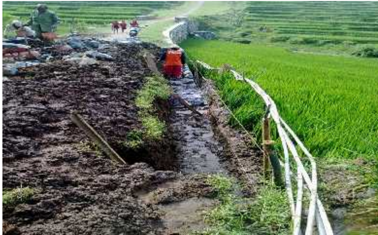
Kondisi 0 % Talud Lingkungan Kedungrejo RT 1
