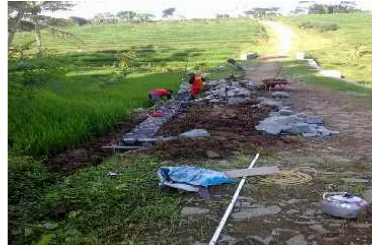
Kondisi 50 % Talud Kedungrejo RT 1
